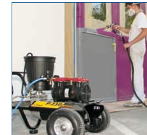
Nella spruzzatura Airless la vernice viene nebulizzata sull'apposito ugello senza l'ausilio dell'aria compressa (foto: SATA GmbH & Co. KG. A questa pistola volendo si può allacciare aria compressa per ottenere una nebulizzazione ancor più fine).
