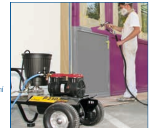
Při bezvzduchovém stříkání (Airless) se rozprašování laku realizuje na rozprašovací trysce bez podpory stlačeného vzduchu (foto: SATA GmbH & Co. KG. Při této pistolí může být pro ještě jemnější rozprašování alternativně připojen stlačený vzduch.)
