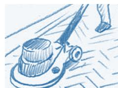
3. Dopo aver lasciato essiccare per ca. 30 min. lucidare la superficie con una lucidatrice monodisco a pad bianco o con un panno di cotone ruvido. Evitare assolutamente di trattare con acqua.
