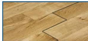
Onregelmatige voegenvorming door kantenverlijming
