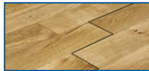
Nepravidelné mezery vzniklé vlivem slepení hran
