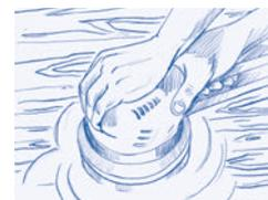
3. Nach ca. 5 Stunden Trockenzeit polieren Sie die Oberfläche mit einer Bürste, einem weißen Schleifvlies oder einer Lammfellscheibe auf Glanz. Bei strapazierten Fußböden ist eine zweite Behandlung (Schritte 2 + 3) erforderlich.
