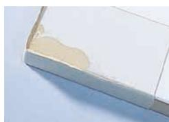
**2.** Ora riempite l'angolo scheggiato con la miscela di riempitivo. Premete fermamente la pellicola trasparente sul riempitivo per impedire la formazione di bolle d'aria. In questo modo la successiva carteggiatura risulterà più facile. Rimuovete la pellicola solo una volta che il riempitivo è indurito completamente (attendere almeno 15 minuti).
