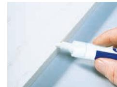
**2.** Passate la matita sull'area danneggiata, tenendola leggermente inclinata rispetto al bordo. Se serve una seconda applicazione, lasciate asciugare bene la prima.
