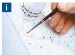
3. Riparate l'area riempita usando la pittura colorata "originale" (nell'esempio, Wigranit® Novacolor R9016). Con un po' di pratica, potrete utilizzare anche un aerografo per pitturare l'area.
