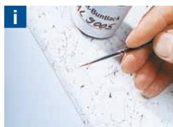
4. Ripristinate ora i motivi mancanti, usando ancora una volta la pittura colorata "originale" (nell'esempio, Wigranit® Novacolor R9005).
