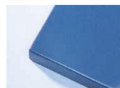
**7.** Dopo un'adeguata carteggiatura intermedia, applicate sull'area pitturata una mano di finitura con Crystallit® Vernice incolore. Poiché il danno è stato riparato prima della verniciatura, la finitura opaca ora non è più visibile.
