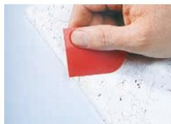
1. Miscelate Correct Mastice a due componenti per legno 100:3 con la pasta indurente. Assicuratevi che il rapporto di miscelazione sia sempre corretto e che riempitivo e indurente siano miscelati omogeneamente. Ora riempite l'area danneggiata con la miscela di riempitivo.
