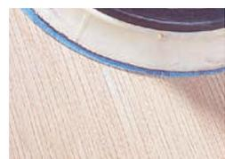
**2.** Una volta che il prodotto è sufficientemente asciutto, potete passare alla carteggiatura dell'area. Nel caso in cui siano ancora visibili delle piccole imperfezioni (bolle d'aria), riempite nuovamente il graffio. Ora, potete ripristinare le porosità con un raschietto.
