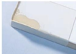
2. Füllen Sie nun die Ecke mit dem angemischtem Holzspachtel. Drücken Sie die Klarsichtfolie fest in den Spachtel, um Luftlöcher zu vermeiden. Dies erleichtert Ihnen die spätere Schleifarbeit. Nehmen Sie die Folie erst nach Aushärtung des Spachtels (frühestens nach 15 min.) ab.
