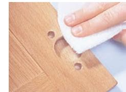
**5.** Eventuell entstandenen Sprühnebel mit feiner Stahlwolle (000) oder weißem Schleifvlies entfernen. Hierbei mit wenig Druck arbeiten, um keine Schleifspuren zu verursachen.
