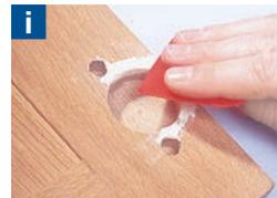
**1.** Mischen Sie den Correct 2K-Holzspachtel CHS mit der Härterpaste 100:3. Wichtig ist die Einhaltung des Mischungsverhältnisses und die homogene Vermengung von Spachtel und Härter. Füllen Sie die Schadenstelle mit dem angemischten Holzspachtel.
