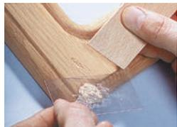
**2.** Füllen Sie das Loch mit dem Correct Holzkitz CHK. Tiefe und große Löcher müssen in zwei Arbeitsschritten mit entsprechender Zwischentrocknung gefüllt werden.
