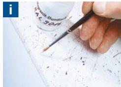
3. Bessern Sie die gespachtelte Fläche mit dem „Original“-Buntlack aus (im Beispiel Wigranit® Novacolor WNC / R9016). Wenn Sie geübt sind, können Sie auch diese Fläche mit der Airbrush-Pistole lackieren.
