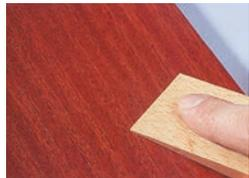
2. Achten Sie darauf, dass Sie das Weichwachs fest mit einem Spachtel in den Kratzer drücken. Nun nehmen Sie das überschüssige Weichwachs ab. Bitte keine scharfkantigen Spachtel verwenden, da diese die lackierte Oberfläche beschädigen. Um alle Reste abzukommen, können Sie die Fläche noch mit dem weißen Schleifvlies abreiben.
