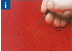
1. Füllen Sie den Kratzer mit „Original“-Buntlack (im Beispiel Wigranit® Novacolor Buntlack WNC). Benutzen Sie hierzu einen der Pinsel aus dem Correct Tuschkasten.
