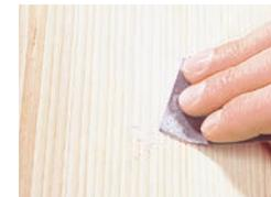
1. Schleifen Sie den Fleck aus dem Holz, bis er nicht mehr sichtbar ist. Der Endschliff muss mit 400-er Körnung erfolgen.
