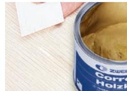
**1.** Füllen Sie die Fehlstelle mit Correct Holz kitt CHK in dem passenden Holzton. Achten Sie darauf, dass Sie einen kleinen „Berg“ auftragen!
