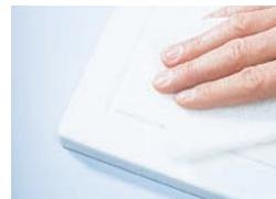
**3.** Eventuell entstandenen Sprühnebel mit feiner Stahlwolle (000) oder weißem Schleifvlies entfernen. Hierbei mit wenig Druck arbeiten, um keine Schleifspuren zu verursachen.
