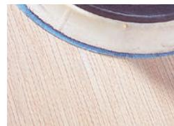
**2.** Nach ausreichender Trocknung können Sie die Stelle plan schleifen. Sollten noch kleine Löcher (Luftblasen) sichtbar sein, müssen Sie diese nochmals verfüllen. Poren können Sie jetzt mit einer Zieh Klinge nachziehen!
