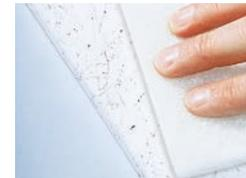
6. Eventuell entstandenen Sprühnebel mit feiner Stahlwolle (000) oder weißem Schleifvlies entfernen. Hierbei mit wenig Druck arbeiten, um keine Schleifspuren zu verursachen.
