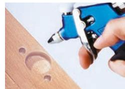
**4.** Die retuschierte Stelle muss nun mit dem „Original“-Klarlack (im Beispiel Crystallit® 2K-PUR Klarlack CL 8) „ansatzlos“ lackiert werden. Um ansatzfrei lackieren zu können, muss der Lack mit der maximalen Verdünnungszugabe appliziert werden (siehe Technisches Merkblatt unter [www.zweihorn.com](http://www.zweihorn.com)).
