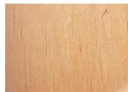
4. Der Fehler ist nun nicht mehr sichtbar und wird durch die Verwendung des „Original“-Materials auch gleich „altern“ wie der Rest der Fläche.
