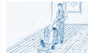
2. Im Wandbereich hinter Ihnen bleibt nach Schritt 1 ca. ein Meter Parkett ungeschliffen. Diesen Bereich müssen Sie nun in umgekehrter Richtung schleifen. Der Übergang muss ansatzfrei geschliffen werden, damit man diesen nach dem Lackieren oder Ölen nicht sieht. Idealerweise sollte dieser Bereich gegenüber der Fensterfront (Lichteinfall) liegen! Ist dies nicht möglich, bitte mit Schritt 3 fortfahren (ansonsten Schritt 4)!
