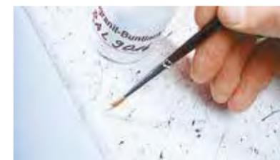
**3.** Bessern Sie die gespachtelte Fläche mit dem „Original“-Buntlack aus (im Beispiel Wigranit® Novacolor 2K-PUR Buntlack WNC/R9016). Wenn Sie geübt sind, können Sie auch diese Fläche mit der Airbrush-Pistole lackieren.
