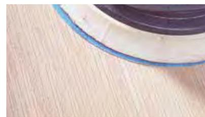
2. Nach ausreichender Trocknung können Sie die Stelle plan schleifen. Sollten noch kleine Löcher (Luftblasen) sichtbar sein, müssen Sie diese nochmals verfüllen. Poren können Sie jetzt mit einer Ziehklinge nachziehen!
