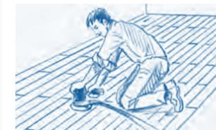
3. Sind aus Schritt 2 Übergänge des Schleifens (Wendepunkte o. Ä.) sichtbar, müssen Sie diese von Hand nacharbeiten. Achten Sie darauf, dass Sie das in der ursprünglichen Schleifrichtung tun! Weiter mit Schritt 4.
