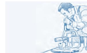
5. Bearbeiten Sie nun den Randbereich mit der Randschleifmaschine (Körnung siehe Tabelle auf Seite 110, Feinschliff). Um wirklich sicher zu sein, dass keine Schleifübergänge zu sehen sind, empfiehlt sich ein letzter Feinschliff mit einem Tellerschleifgerät. Nach dem Absaugen ist der Boden bestens für die Lackierung oder das Ölen vorbereitet!
