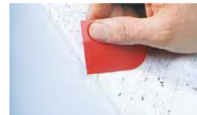
**1.** Mischen Sie den Correct 2K-Holzspachtel CHS mit der Härterpaste 100:3. Wichtig ist die Einhaltung des Mischungsverhältnisses und die homogene Vermengung von Spachtel und Härter. Füllen Sie die Schadenstelle mit dem angemischten Holzspachtel.
