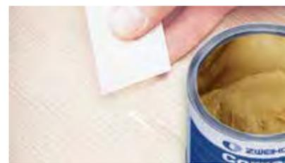
1. Füllen Sie die Fehlstelle mit Correct Holz kitt CHK in dem passenden Holzton. Achten Sie darauf, dass Sie einen kleinen „Berg“ auftragen!
