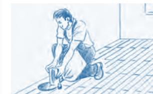
5. Der Mittelschliff erfolgt ebenfalls um 90° versetzt zu dem vorherigen Schleifgang. Bitte gehen Sie dabei vor wie unter Schritt 1–4 beschrieben. **Achtung:** Heben Sie den Schleifstaub für die Fugenkittlösung auf! Bevor Sie mit dem Feinschliff beginnen, saugen Sie den Boden komplett mit dem Staubsauger ab.
