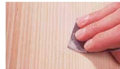
1. Schleifen Sie den Fleck aus dem Holz, bis er nicht mehr sichtbar ist. Der Endschliff muss mit 400er-Körnung erfolgen.
