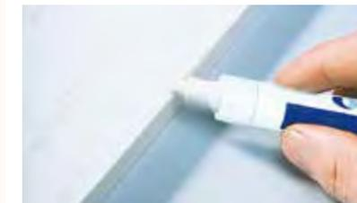
**2.** Ziehen Sie mit dem Stift etwas schräg zur Kante über die Schadenstelle. Sollte ein zweiter Auftrag notwendig sein, müssen Sie eine gewisse Zwischentrockenzeit einhalten!
