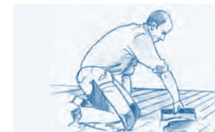
2. Damit alle kleinen Fugen und Risse erfasst werden, verteilen Sie die Füllmasse mit einem breiten flachen Spachtel (rostfrei!) gleichmäßig auf dem gesamten Fußboden.
