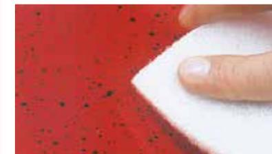
4. Eventuell entstandenen Sprühnebel mit feiner Stahlwolle (000) oder weißem Schleifvlies entfernen. Hierbei mit wenig Druck arbeiten, um keine Schleifspuren zu verursachen.
