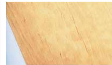
**3.** Der Fehler ist nun nicht mehr sichtbar und wird durch die Verwendung des „Original“-Materials auch gleich „altern“ wie der Rest der Fläche.
