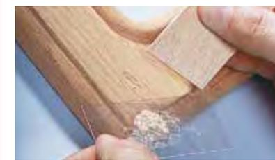
2. Füllen Sie das Loch mit dem Correct Holz kitt CHK. Tiefe und große Löcher müssen in zwei Arbeitsschritten mit entsprechender Zwischentrocknung gefüllt werden.
