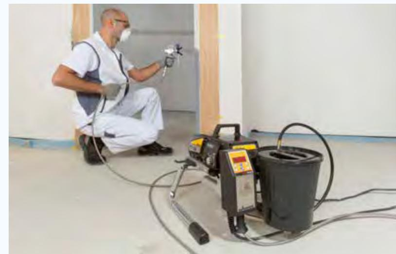
Lackierarbeiten mit einem typischen Airless-Gerät (Foto: J. Wagner GmbH)
