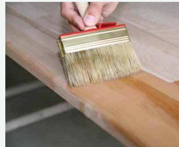
Der Auftrag des Öles muss mit einem öfsten Pinsel erfolgen und wird zuerst längs, dann quer zur Maserung vorgenommen.
