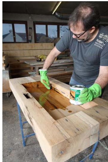
Das Naturtrend Hartwachs-Öl NHWO wird mit dem Pinsel aufgetragen . Foto: Akzo Nobel Wood Coatings GmbH – Geschäftsbereich Zweihorn
